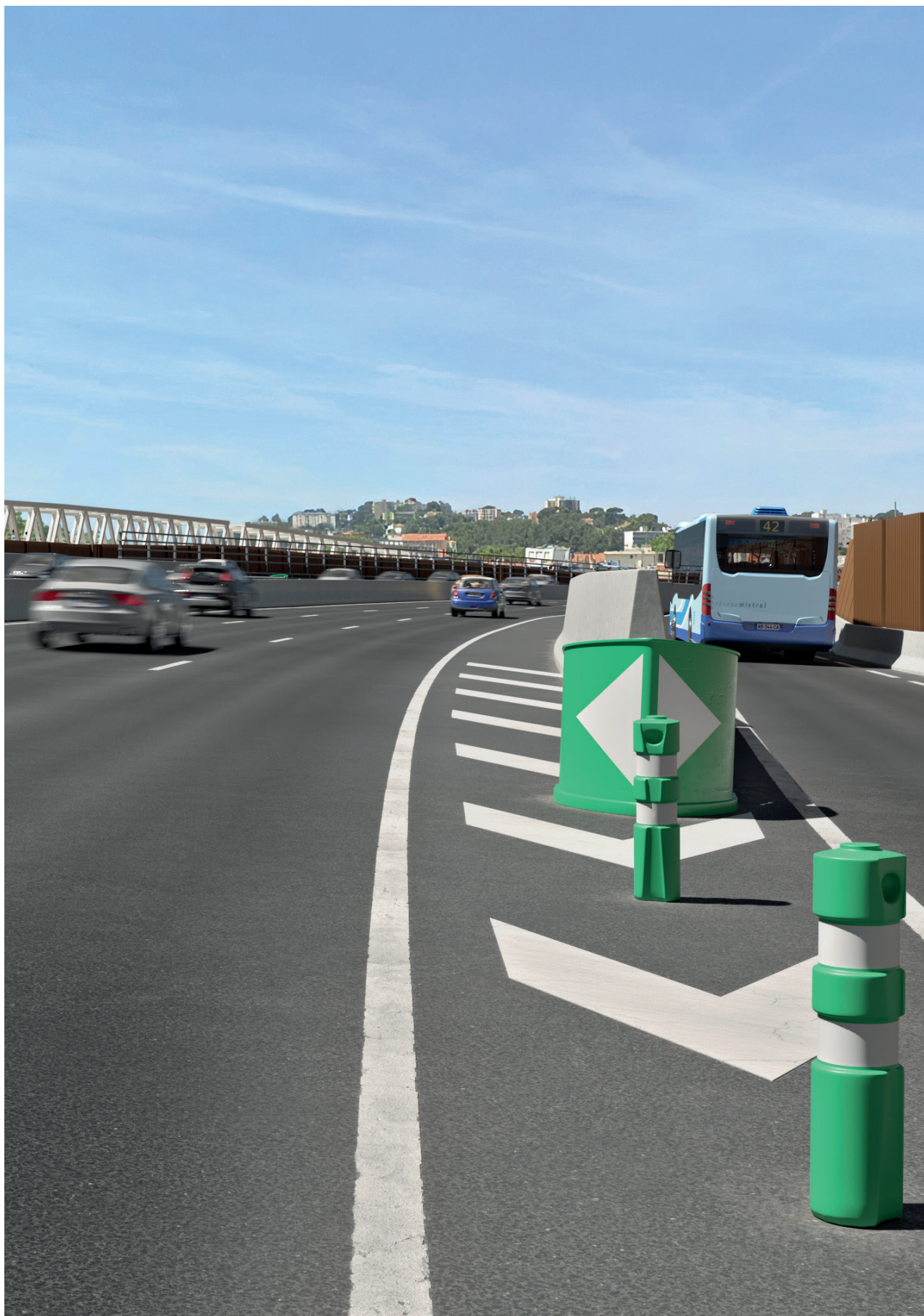
Projet A57 Source : Vinci autoroutes
