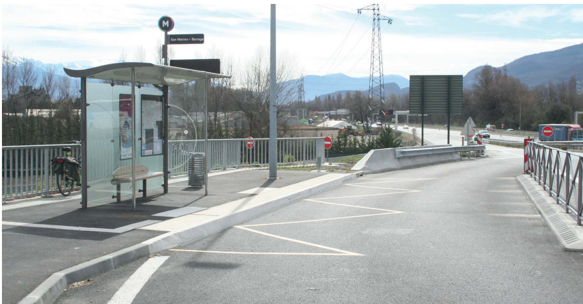
Aménagement d'un arrêt TC séparé sur une bretelle de sortie – A48 Saint-Égrève
