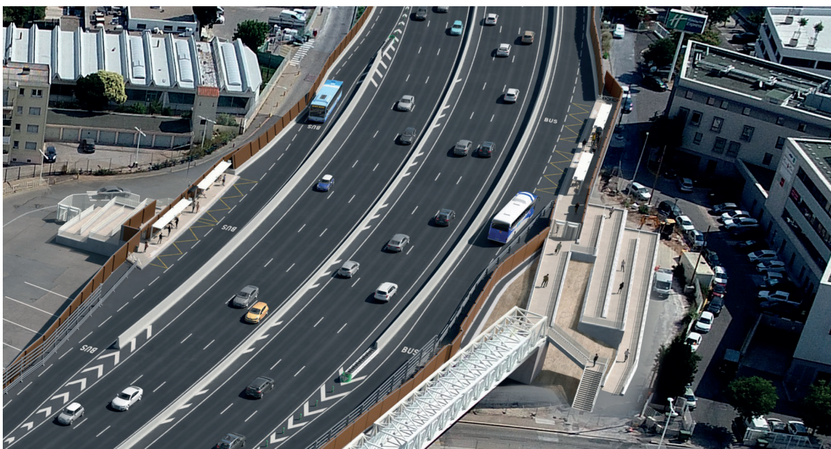
Aménagement d'une rampe d'accès à l'arrêt Sainte-Musse à Toulon sur l'A57
