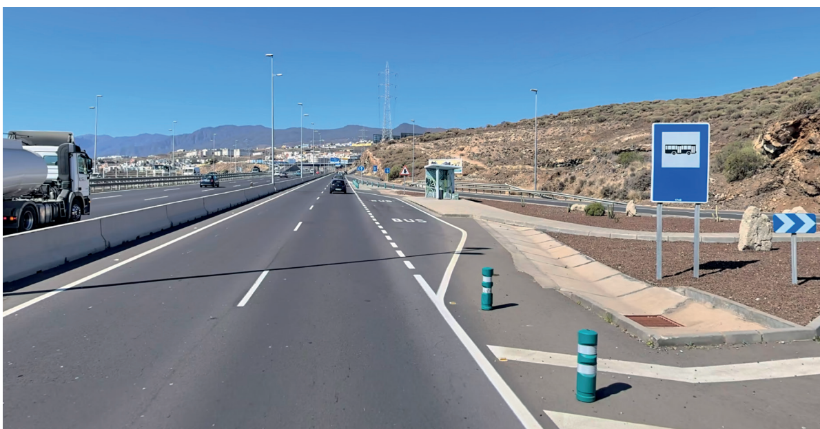
Exemple d'un arrêt TC sur une bretelle d'entrée en Espagne
