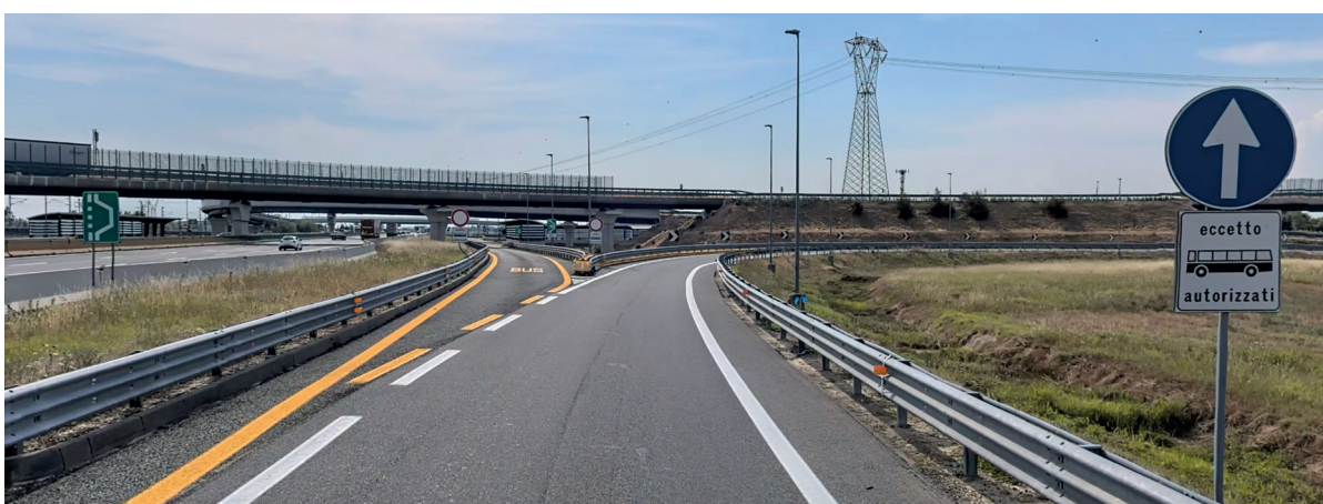
Cas d'une sortie par la gauche sur bretelle sur Autoroute A4 – Italie
